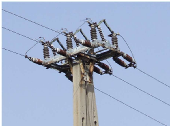
8. Kép Oszlopcsúcson elhelyezkedő gerincbontó oszlopkapcsoló
