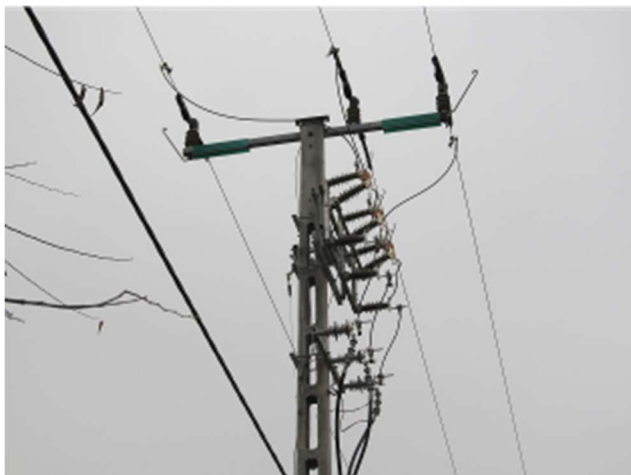
14. Kép Függőleges elhelyezésű oszlopkapcsoló
