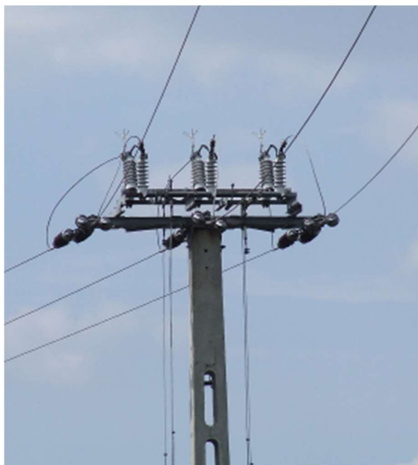
9. Kép Oszlopkapcsoló kétoldalas hajtásvezetéssel
