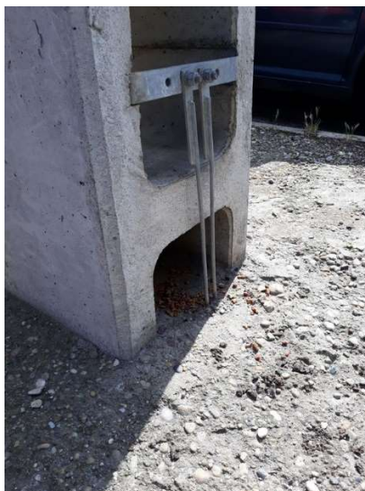
22. Kép Oszlop földelés nem sérülhet
