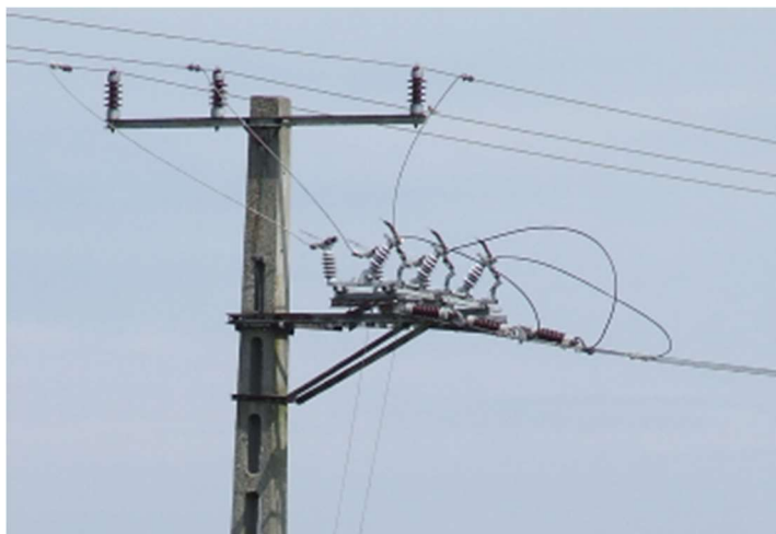
10. Kép Vízszintes leágazó oszlopkapcsoló
