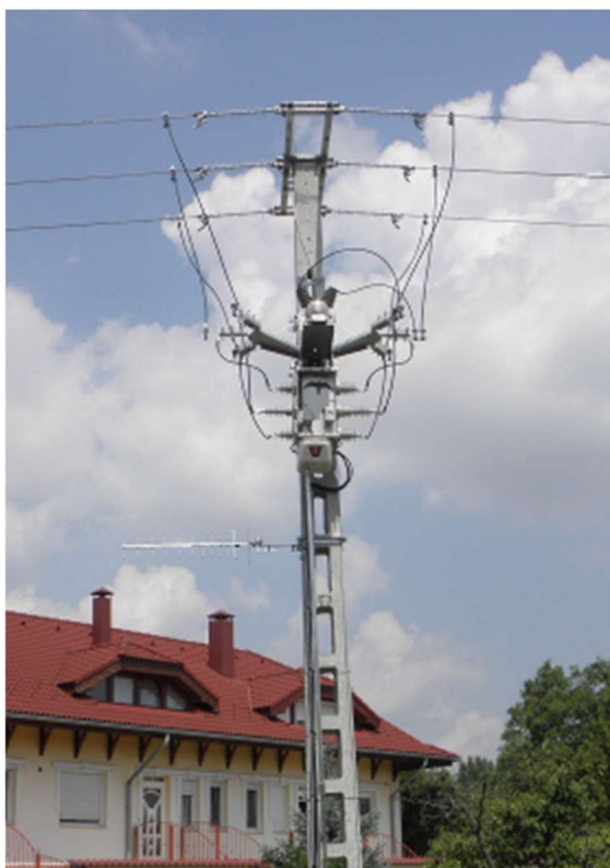
13. Kép Burkolt szabadvezetékes bekötésű TMOK
