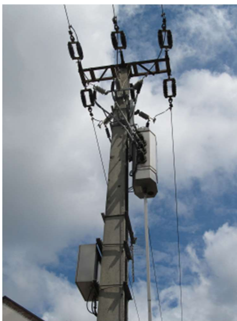
12. Kép Kábeles bekötésű TMOK
